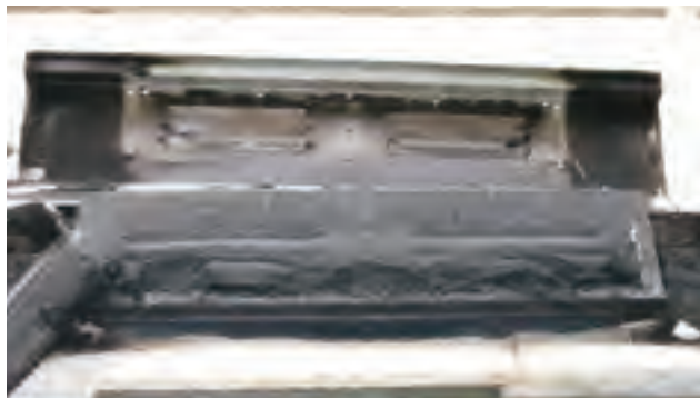
【熱膨張後の換気棟内部】
